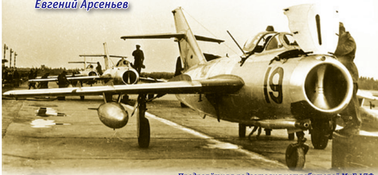
Предполётная подготовка истребителей МиГ-17Ф, оборудованных прицелом АСП-4НМ и радиодальномером СРД-1 «Радаль-М»
