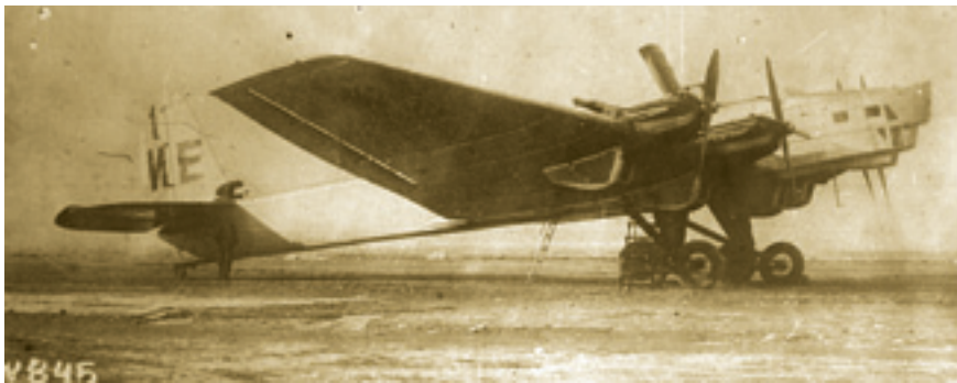
Экспериментальный самолет ТБ-3Р с двигателями М-34Р с улучшенной аэродинамикой. Октябрь 1935 г.
