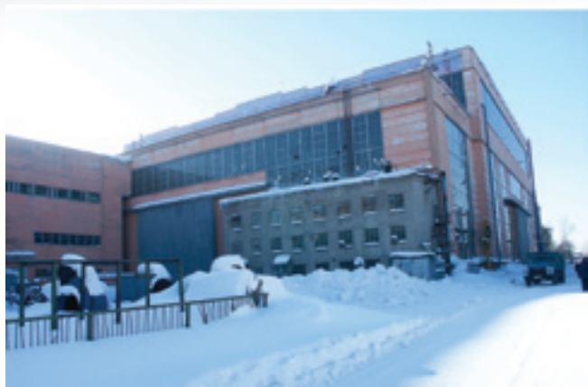
ФГУП «СибНИИА» - корпус до реконструкции
